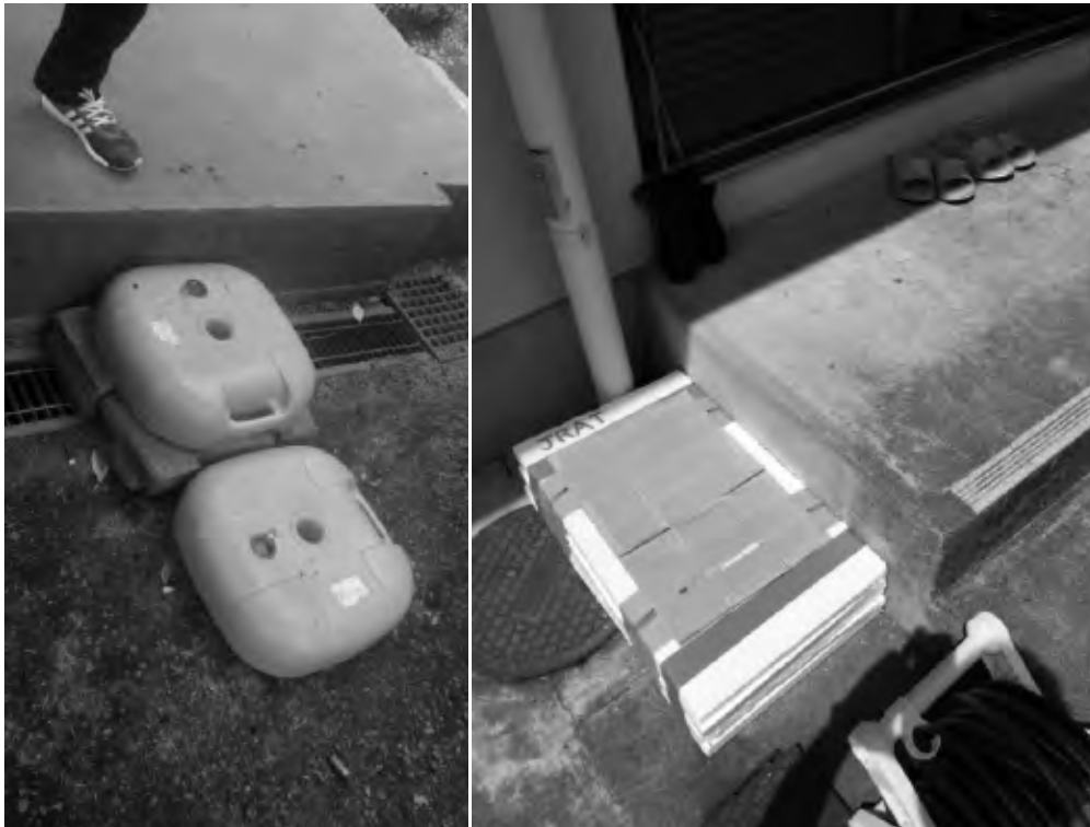
写真 1 屋外の段差解消
