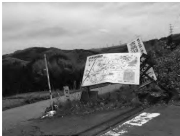
写真1 崩落による通行止め
