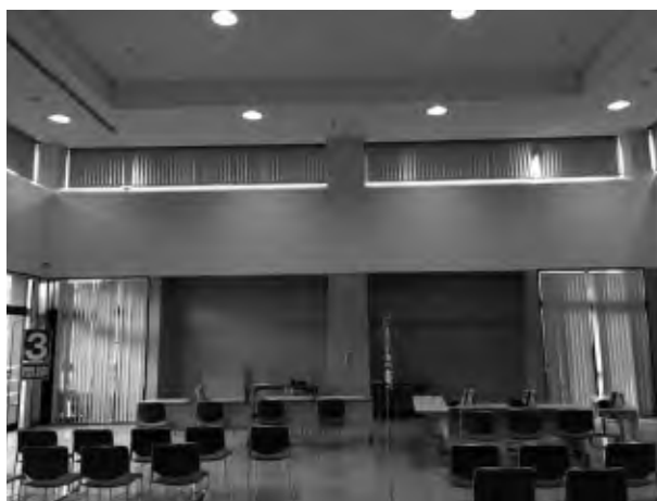
写真1 宇城市保健福祉センター 天井が崩壊し避難所として使用できなくなった。
