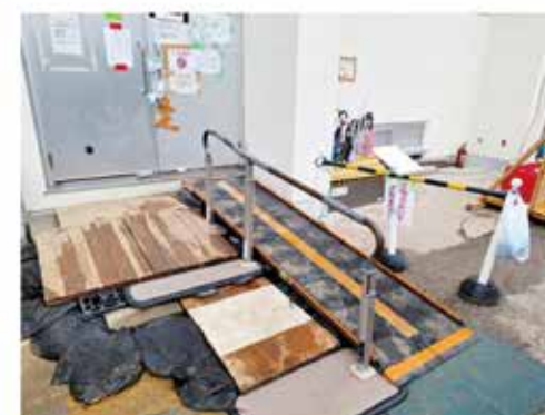
写真4. 避難所入り口のスロープ設置
