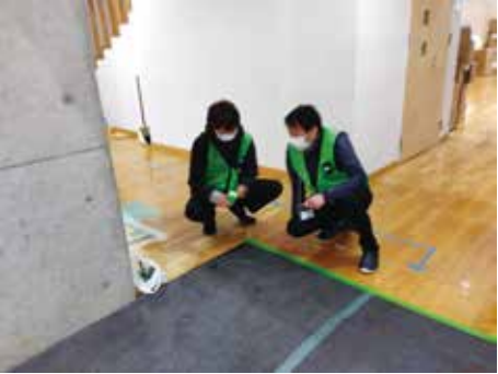
写真1 避難所の段差解消マットの修繕
